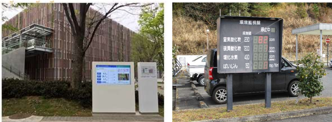
左：武蔵野クリーンセンター 右：中播北部クリーンセンター
