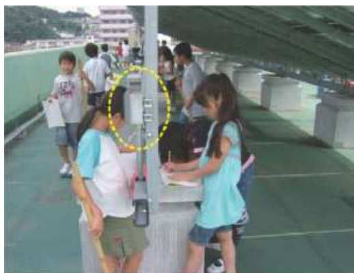
太陽電池モジュールの近くに電気を取り出すことのできるコンセントが設置されている。
